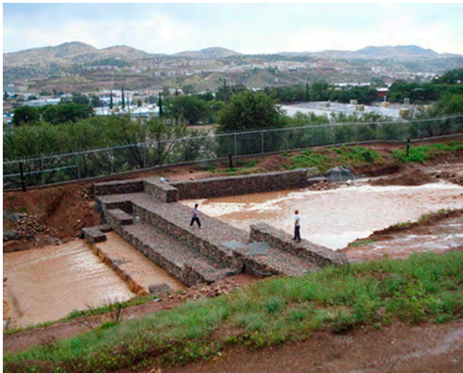
Nogales, Sonora, Detention Basin La Bellota.
